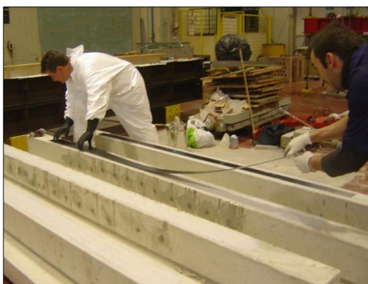
Figura 16 - Aplicação dos laminados de fibra de carbono (DUARTE, 2011).
