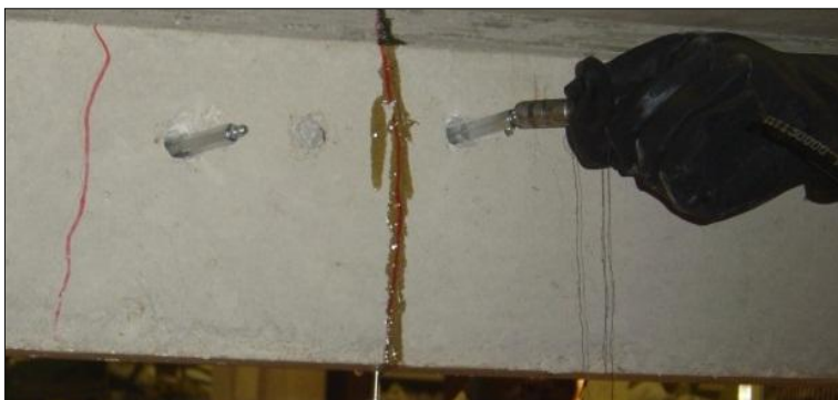
Figura 15 - Aplicação de resina através de injetores (DUARTE, 2011).
