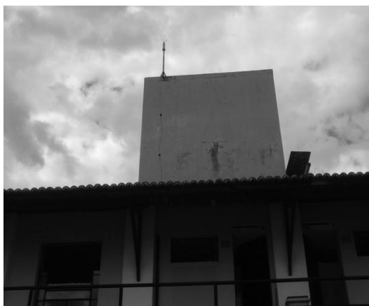
Figura 7 - SPDA tipo Franklin Bloco da Computação-UVA
