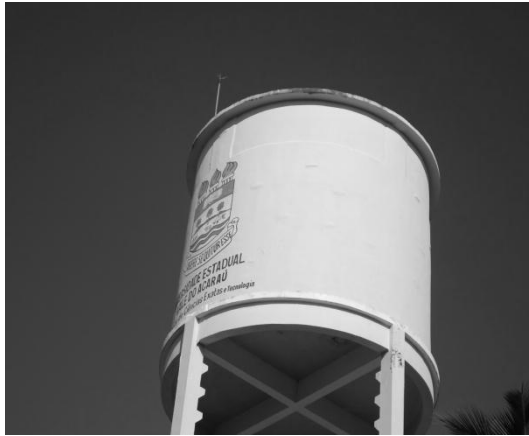
Figura 8 - SPDA tipo Franklin Caixa d'água da UVA
